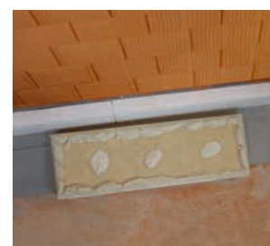
Si le support a des irrégularités, utiliser la technique de collage boudin et plot
