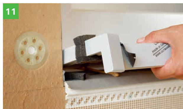
Pose de l'appui de fenêtre. Prévoir un débord de l'appui de 3 cm minimum par rapport à la façade enduite. Astuce: Garder les compribandes au frais afin d'éviter une dilatation trop rapide.
