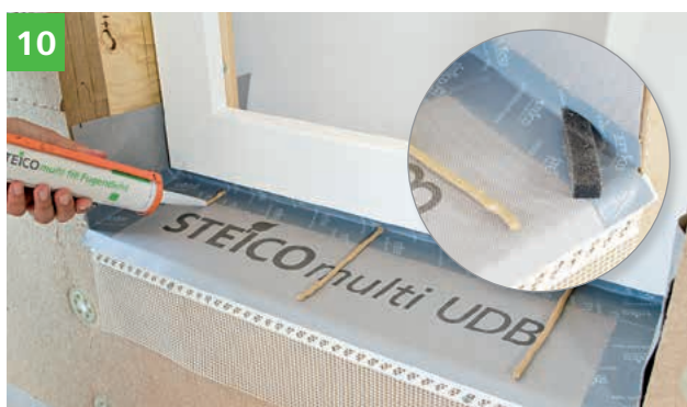
Encollage du support d'appui STEICOfix par des cordons de mastic-colle STEICOmulti fill espacés de 30 cm max. Astuce: les compribandes collées en biais permettent d'évacuer l'humidité vers le profil goutte d'eau
