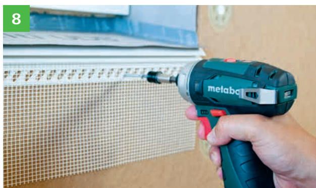
Fixation du profil goutte d'eau et du treillis d'armature sous l'appui de fenêtre à l'aide de vis ou d'agrafes en acier dans le panneau isolants.
