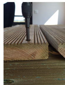
3. Plaquage de la lame sur la lambourde
