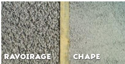
Mise en place à la règle (avec compactage à la taloche pour le ravoirage)
