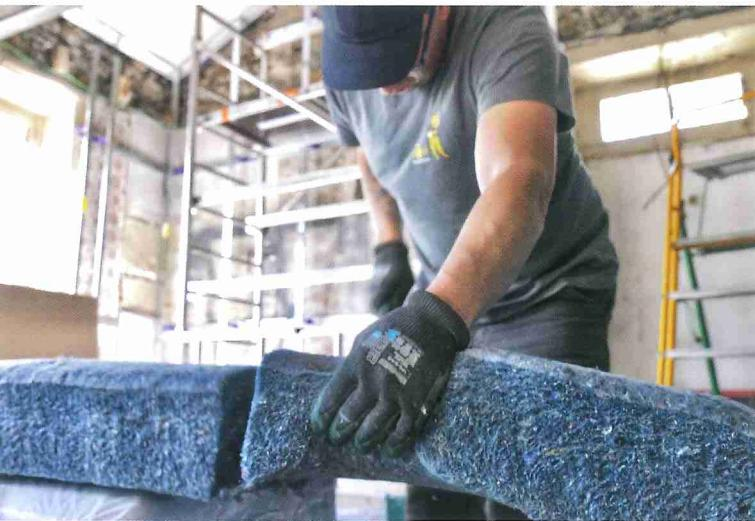
Le procédé COTOWOOL® FLEX 25 fait l'objet d'Avis Technique (n°20/19-439\_V4 Application murs, 20/19-440\_V3 Application combles). Il est destiné à l'isolation thermique en travaux neufs ou en rénovation des bâtiments suivants :
